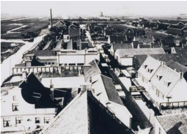
▲ gedifferentieerde bebouwing achter kerk
